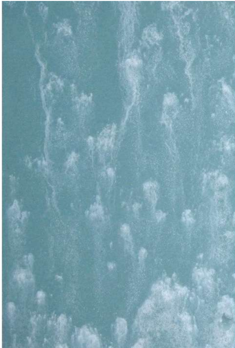
Рисунок 16 – Коррозия металла балл WRi3
