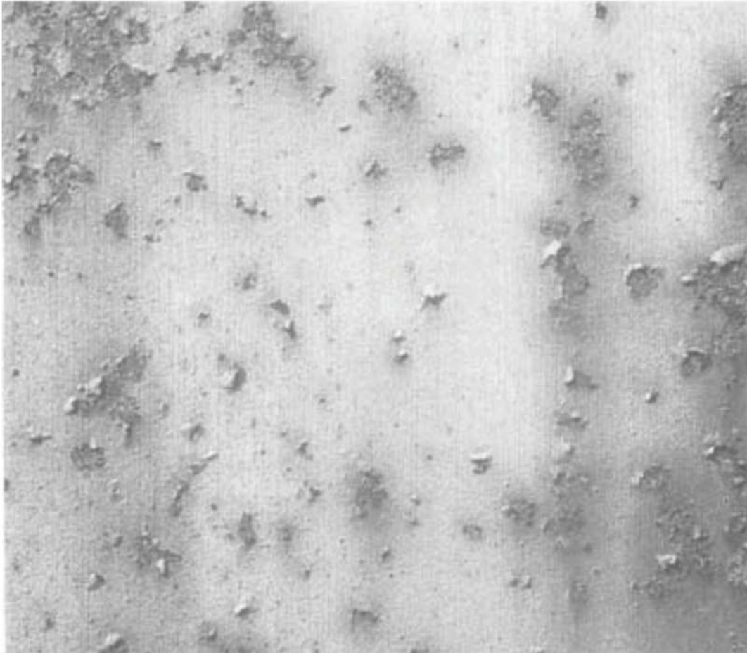
Рисунок 12 – Коррозия металла балл Ri4
